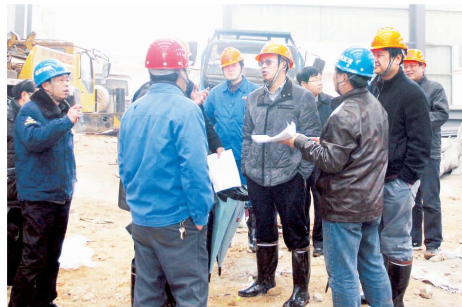
▲集团公司总经理翟保全(中)在重点工程施工现场检查指导工作。 方圆 摄
