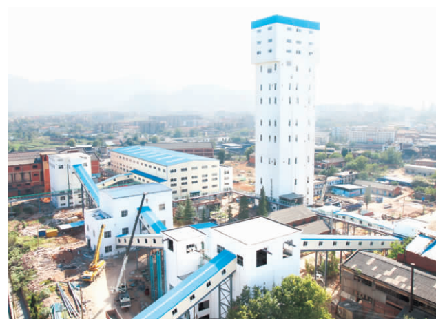
▲建设后的矿区场景。 秦霄 摄
