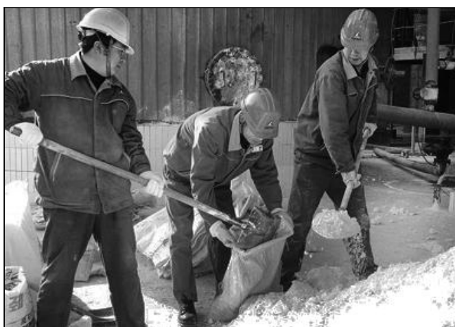
氧化铝四分厂积极贯彻落实弹性生产组织方案,杜绝外委检修,主动承担各项清理任务,全力以赴投入挖潜增效、控亏增盈生死保卫战中。图为员工义务清理2号搅拌机槽结垢。摄影报道 张昕
