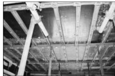
翠溪小区在施工中大胆采用新技术、新材料,选用的“数字化钢性模板支撑组合结构”操作简单,安装拆卸灵活方便,可节省大量材料。上图为工人正在安装模板;左图为数字化钢性模板支撑组合结构。
