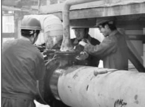
为了对3号焙烧炉系统全面消缺,1月16日、17日,第二氧化铝厂员工放弃休息日,加班加点,顺利完成3号炉T11风机处理、T12检查清理、3号炉排风机油冷器检查、液力耦合器打开检查、3号焙烧炉系统5个盲板抽堵等20余项检修任务。图为检修车间员工正在更换3号风机油冷器。摄影 杨苏哲
