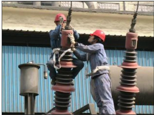
近日,热电厂对2号主变进行计划性检修。此次检修的项目有:绝缘子更换、清洗,瓷瓶套管清洗,开关检查、润滑、传动、试验,过电压保护器试验等20余项,参战人员克服高空作业、空间狭小等不利因素,连续作业,经过10余小时的紧张奋战,顺利完成了全部项目,为电气生产系统的安全稳定运行提供了强有力的保障。图为检修作业现场。摄影报道 张梅
