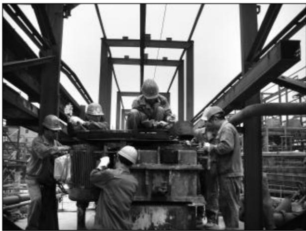
进入秋季，为保证种分槽设备稳定运行，为拜耳法种分分解条件的优化和分解率指标的提高创造条件，第二氧化铝厂对运行中的32台种分槽进行了系统普查。
