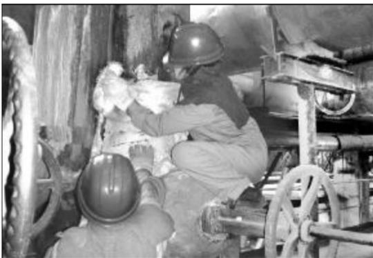
热电厂检修车间充分发挥自主检修力量,主动承担外委检修项目。车间通过内部招聘成立了架子保温班,他们克服现场环境差,高空作业等不利因素,为设备检修的顺利进行积极创造条件。自班组成立两个多月以来,已搭建各类脚手架80余副,修补保温30余项,节约外委费用9万余元。图为女工正在用硅酸岩板对阀门保温进行修补。摄影报道 陈文都
