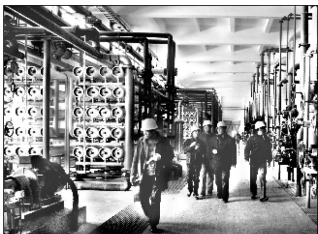
热电分厂员工在晋北鲁能电厂参观考察再生水深度处理。
