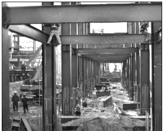
连日来,氧化铝挖潜改造项目建设指挥部人员坚持每天召开工程例会,加强施工管理。施工单位人员克服寒冷天气给施工带来的不便,连续施工抢工期,使项目建设呈现快速推进的良好局面。图为母液蒸发器项现场施工人员正在紧张施工中。摄影报道 李麦莲
