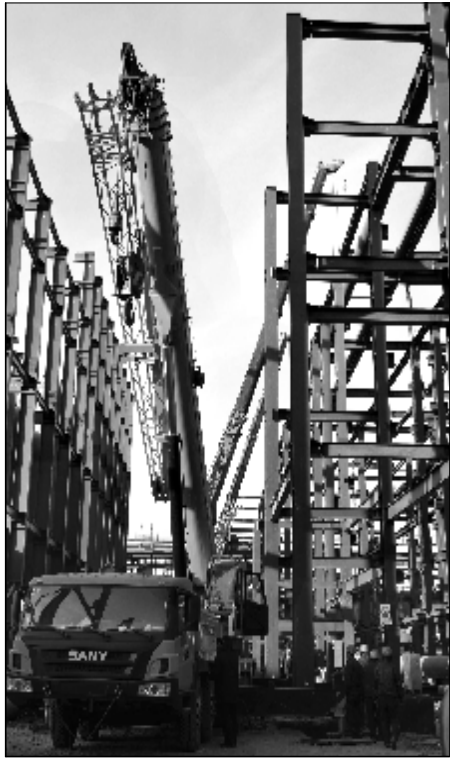
图为高压溶出施工现场。摄影 李麦莲
