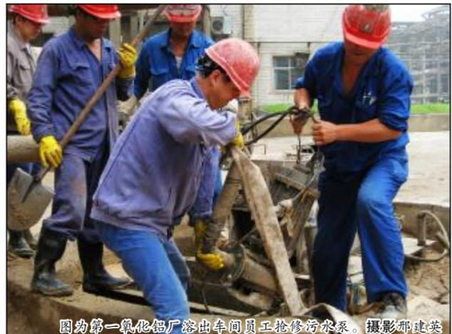
图为第一氧化铝厂溶出车间员工抢修污水泵。摄影郝建英
