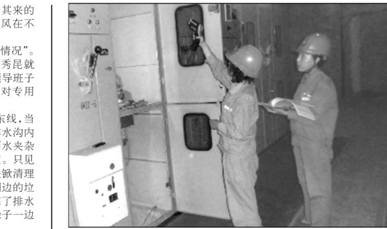
近日,水电分厂一车间根据夏季生产特点,组织专业技术人员对所有高压配电室开展闭灯检查、配电柜开柜测温,先后查处电气发热点及其它隐患5处,均得到及时处理,确保了稳定供电,并把闭灯检查和开柜测温纳入基本生产管理内容。
