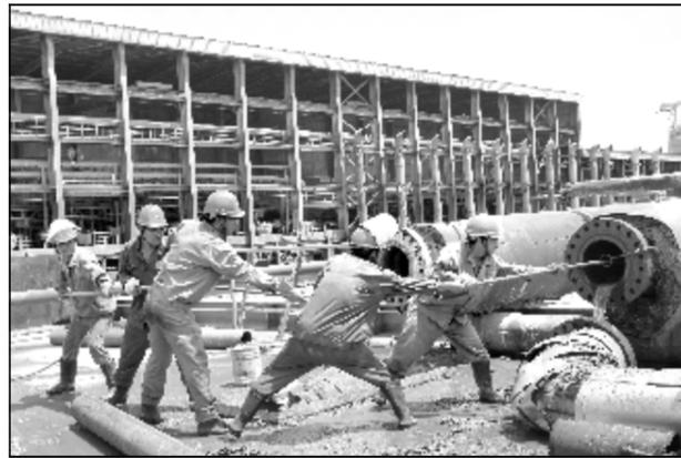
管道结疤是化工生产的常见难题,直接影响着生产效率。近日,检修分厂专业清理队在第二氧化铝厂管道蒸发器清理中,采用两台专业高压水车同时进行双向清洗,取得良好效果。图为清理队员正在精心清洗管道蒸发器。摄影报道 张安泽
