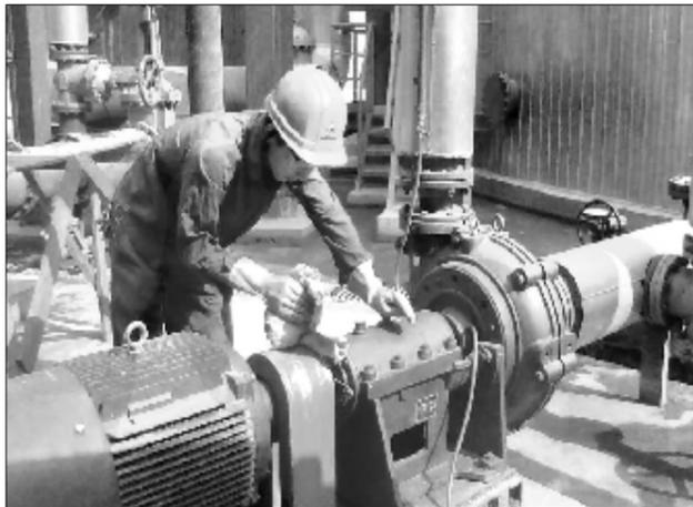
近日,第二氧化铝厂三车间沉降工段对所辖范围内的运行设备进行全面维护与保养,要求作业人员对设备点巡检,周周保养,并在巡检中要通过看、听、闻、摸来判断设备是否正常,对发现的问题要及时汇报,避免因设备故障而影响生产。在此期间,各班组共处理大小问题20余项,使设备正常运行得到保障。
