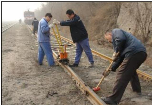
为确保山西企业大宗原材料及产品的到达和出发,春节过后,运输部迅速组织务工人员对交接线一号线进行全面整修。线路检修工克服时间紧、任务重等不利因素,放弃休息时间,加班加点,仅用一天时间完成两天的工作量。共调整轨缝800米,更换大胶垫1000个、小胶垫2000个,灰枕螺帽100余个,单、双弹簧共计220个,确保了物资交接和铁路运输安全。图为检修工检修现场。
