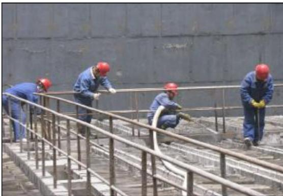
▲ 为保证夏季氧化铝回水的降温效果,水电分厂二车间早准备、早动手,对各泵房冷却设施进行全面检查,包括布水管布水情况、塔盆沉积情况及冷却塔淋水效果等,并制定清理方案,为冷却塔夏季运行做好准备工作。图为冷却塔清理现场。摄影报道 薛秋云
