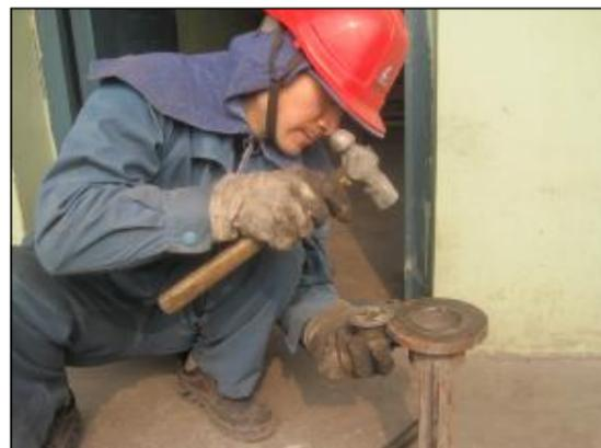
近日，由于10号锅炉冷渣机放渣口下插门出现故障，热电厂检修车间锅炉三班班员经拆卸检查发现，锁母扣丝扣损坏，轴承螺母外缘和轴承不同程度损坏，于是利用空余时间对其进行修理，降低了车间检修费用。图为车间员工正在修复备件。
