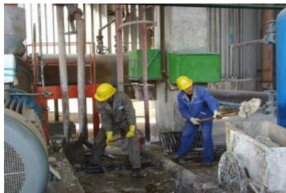
近日,第二氧化铝厂五车间党支部组织党员、积极分子、车间职能人员,在叶滤、立盘等工序开展“下班义务劳动一小时”活动,对车间环境卫生进行全面整治,以实际行动再现奉献精神。经过7天7个小时清理,将叶滤地沟积料和立盘18米地盘的积料清理干净,14米管道架下的积料基本清理完,共清理积料约30吨。图为车间党员正在清理物料。 摄影报道 姚惠娟
