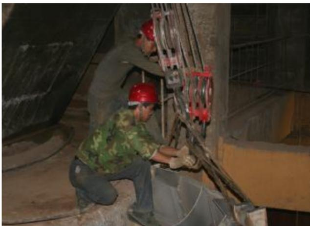
近日,由晋铝建安公司修造车间承担的氧化铝2号、4号斜斗大修任务全面展开。修造车间开工前进行了施工安全技术交底,制定了详细的施工技术质量方案,同时在设备和工器具上进行了充足的配备。针对作业空间狭窄、吊装难度大、钢丝绳错综复杂等问题,施工人员克服任务重、高空作业、灰尘大、温度高等一系列困难,默契配合,利用多台卷扬机结合手动倒链,严格执行质量安全技术标准,力保安装数据误差控制到最小,精心施工。目前,2、4号斜斗大修正在按施工节点顺利开展。图为施工人员正在拆卸链板。
