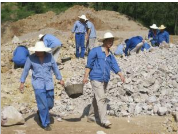
近日,孝义铝矿剥离一车间干部员工共20余人,每天抽出3、4个小时,聚集在孝义铝矿二期铝矿石堆场,头顶烈日,人工从铝矿石堆场中捡出废石,进一步提高矿石品位。图为员工从铝矿石堆中捡出废石场景,平均每天捡出三到五吨。
