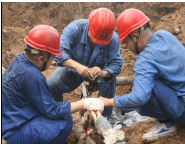
夏季以来，为确保生产生活用电线路畅通，水电分厂综合车间检修人员多次在泥泞的野外查找线路故障，连续作业，恢复断电线。图为综合车间一次班员工在泥坑中处理电缆故障。摄影报道 李垣
