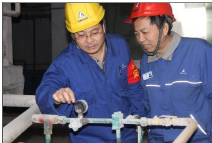
10 月 23 日，第一氧化铝厂针对现场施工隐患、机械票制度落实开展外委施工安全大检查。共发现各类隐患 30 余处，由安全环保科对隐患进行汇总备案后，对各类隐患分类整理，同时按照安全“闭环管理”向车间下发整改指令。
