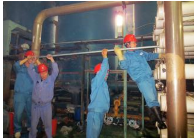
近日,热电厂化学车间针对5号反渗透导电度增大、硅含量超标的状况,经多次研究讨论后,组织车间全体职能人员对老系统5号反渗透管道进行清洗和120根膜元件更换。更换后进一步降低了酸、碱消耗,提高了阳床、阴床、混床的运行周期。图为车间职能人员正在清洗5号反渗透管道及对膜元件进行更换。 摄影报道 杨苗
