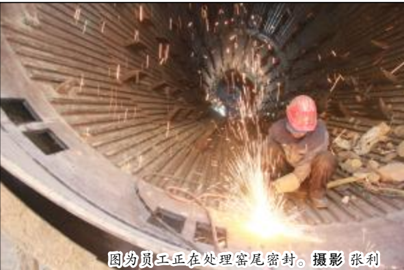
图为员工正在处理窑尾密封。摄影 张利
