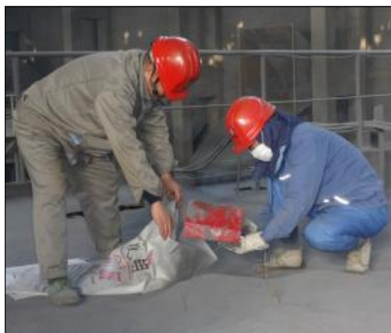
连日来,热电分厂锅炉车间党支部以现场环境卫生整治为重点,进行扫炉、设备除锈刷漆、卫生死角清理等,给员工创造干净整洁舒适的工作环境。图为车间组织党员干部对7号锅炉集汽联箱平台进行彻底清扫。摄影报道 张瑞
