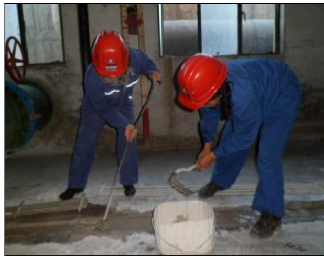
近期,水电分厂一车间厂南泵房水质较差,造成泵房内排水地沟沉积严重,班组员工认真负责,根据沉积情况,不定期对地沟进行清理,保证地沟畅通,营造良好的工作环境,用实际行动实现文明生产。图为岗位员工正在清理地沟淤泥。摄影报道 张芳玲
