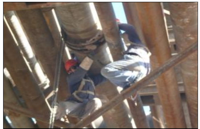
近日，工业回用水进入氧化铝厂区的架空管道堵塞严重，影响着整个厂区的供水压力，水电分厂计划对供水管道进行高压疏通，但管道上的直径500毫米的蝶阀损坏，必须拆除，水电分厂一车间接到任务，立即组织精兵强将，经过11个小时的连续奋战，提前完成了蝶阀的更换，为后期整体管网疏通创造条件。
