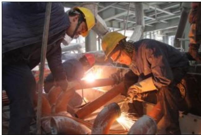
12月18日,第一氧化铝厂焙烧车间抓住热电厂煤气板检修的有利时机,及时联系晋铝建安公司进厂,协同对透气性差的3号焙烧炉出料斜槽帆布及腐蚀严重的壳体冷却器部分管道进行更换,同时对烟道结疤以及电收尘进行常规清理。图为检修维护现场。
