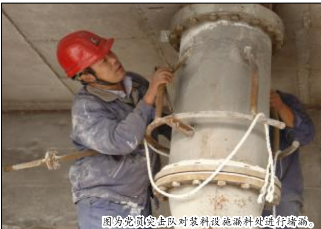
图为党员突击队对装料设施漏料处进行堵漏。
