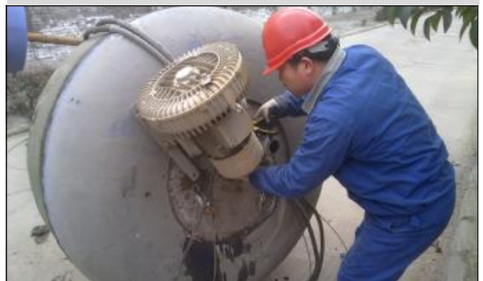
近日,生活污水处理主体设施生物曝气池两台曝气设备出现故障,严重影响污水处理环保达标工作,水电分厂排水车间检修员工斗严寒、赶进度完成了维修任务,确保了水处理工艺的的稳定运行。摄影报道 冯斌
