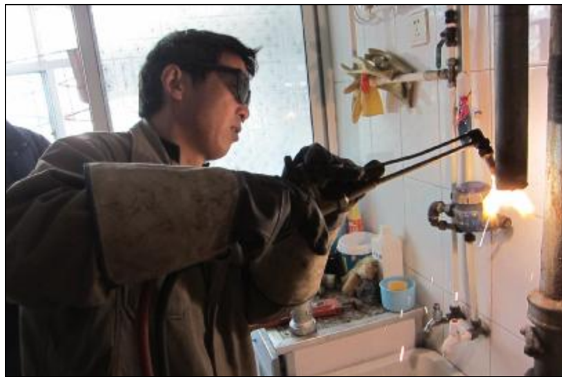
为贯彻落实企业两会精神,新春伊始,生活服务中心维修二车间践行“贴心服务,精彩生活”的服务理念,以住户利益为出发点,优化水电暖报修工作流程,推行“小修不过夜,大修有计划”承诺服务,力求使维修服务更加快捷、方便,进一步提升维修及时率和住户满意度,打造物业服务品牌。图为维修二车间技术人员入户处理上水管阀门堵塞故障。摄影报道 王海雷
