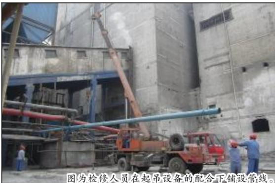
图为检修人员在起重设备的配合下铺设管线。
