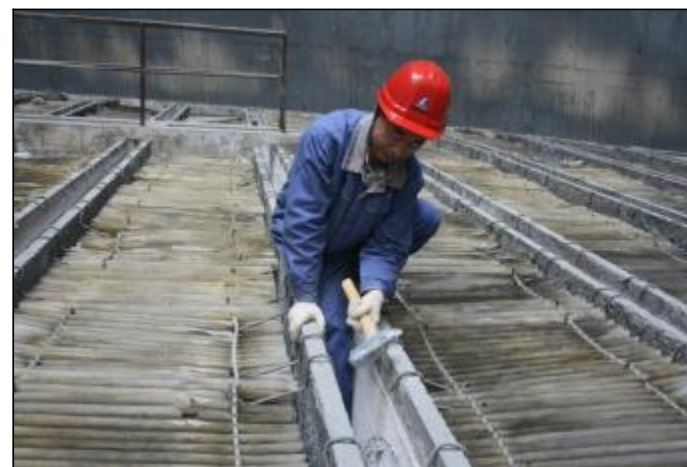
4月30日,水电分厂组织40余名党员干部员工对80万吨循环水3号冷却塔喷头进行更换安装,经过3个小时的奋战,检查清理了1200多个喷头,更换了530个喷头,圆满完成了清理任务,确保冷却塔系统按时投运。图为员工正在清理管道。摄影报道 米增霞
