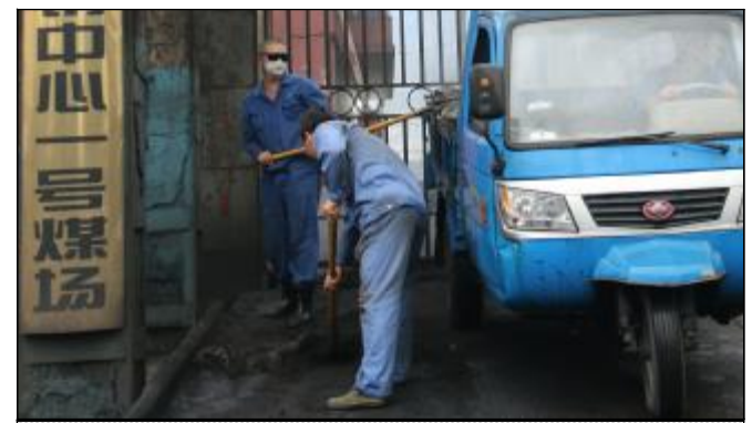
6月29日,营销中心党员骨干和燃料检验科全体员工冒雨整治1号煤场、2号煤场以及马路沿线现场环境,集中清理了煤场主干道旁废弃的平房、废弃电线杆、路障隔离墩、工业垃圾、路边杂草,改善了煤场周边环境状况。摄影报道 张斌 原卢平
