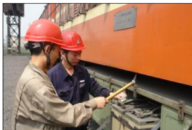
运输部机辆段加强夏季作业安全管理工作,针对当前风大雨多影响作业质量的情况,对机车检修保养作业、大项作业进行重点控制,要求员工坚持做到“四个必须”;必须二人以上方可进行作业,上下机车必须要站稳抓牢,机车出库作业前必须要绕车巡检,作业时必须要挂好禁动牌。图为机辆段两名员工检查机车出库情况。摄影报道 丁剑峰
