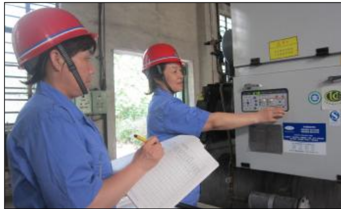
近日,生活服务中心维修二车间党支部引导党员确立改善点,对“调整制冷站送气时间,降低能源消耗”这一现象进行攻关。厂前交换站党员群众根据气温变化,灵活调整冷气输送时间,采取“迟开早关”、“热开冷关”等措施,月可节约电耗2万余元。图为技术人员正在记录设备运行指标。
