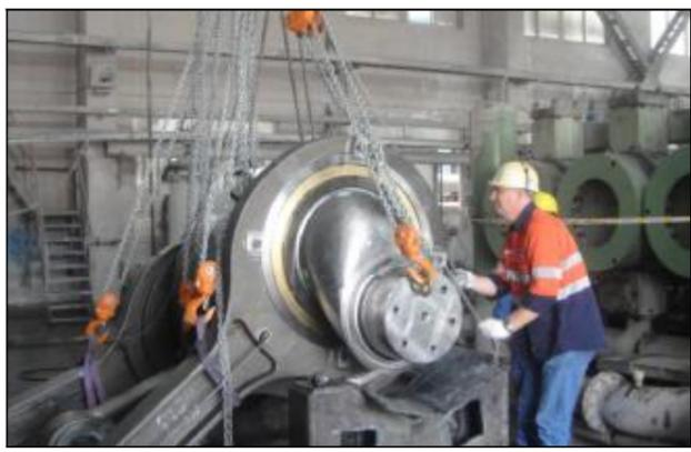
近日,第二氧化铝厂精制车间泥外排荷兰泵轴承大修提前完成,比预定工期缩短两天。外排荷兰泵经过长期运行,出现活塞缸十字滑块晃动磨损的故障,影响到生产系统的正常运行。山西中铝工服联系设备厂家荷兰奇好泵业公司技术人员,来到现场提供技术指导,确定了更换曲轴轴承、动力端支撑轴承及附属备件大修方案。目前施工已完成安装工作,进入了试车阶段。图为国外技术人员指导检修安装作业。
