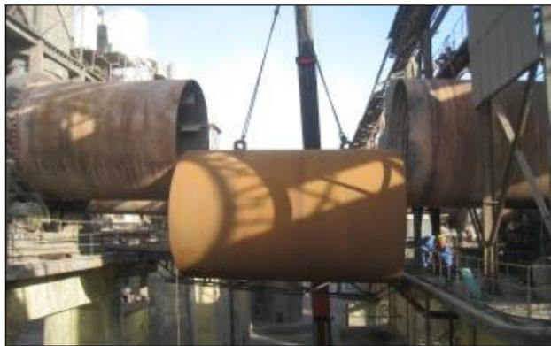
近日,由山西中铝工服承担的第一氧化铝厂5号窑大修工程提前一天顺利完工。铆焊车间提前做好人员配备、工器具、施工网络及倒排工期等准备工作,注重技术交底和安全交底,同时严格交接班制度,严格上道工序为下道工序负责制度,一环紧扣一环,提高检修效率。图为筒体吊装现场。摄影报道 庞文何昌莲
