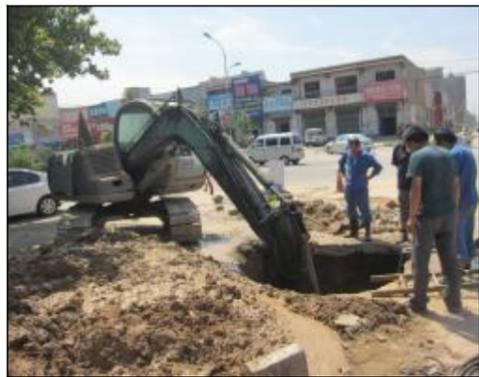
7月24日，位于晋铝西路(12号路西段)的生活水管爆裂，导致朝霞西区和北小区2000余户居民家停水。生活服务中心维修二车间接到报修电话后，组织党员骨干第一时间开始抢修，克服作业面狭窄、管道漏点大、哈夫节安装难度高等困难，连续奋战16个小时，于次日凌晨2点成功修复爆裂管线，恢复正常供水。图为车间员工正在抢修爆裂管线。
