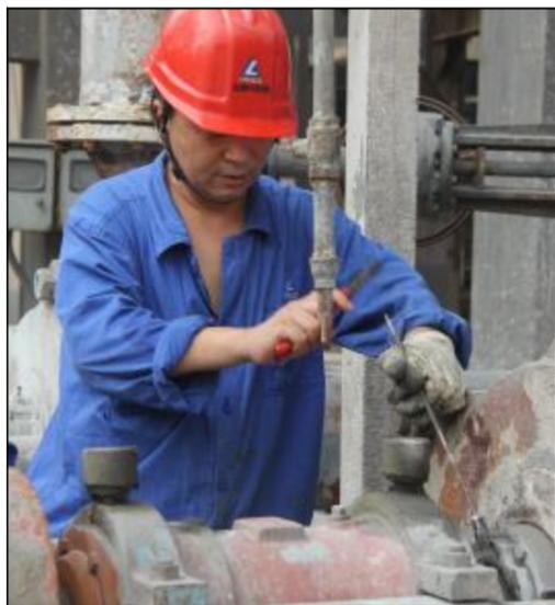
近日，第一氧化铝厂焙烧车间利用4号焙烧炉停车检修有利时机，疏通烟气余热回收泵机封用水管路，提高余热回收系统运行周期。图为车间员工疏通机封水管。
