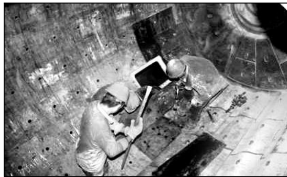
7月15日,由检修分厂检修车间承担的80万吨氧化铝3号棒磨整仓衬板首次更换顺利完工。检修人员克服了高温、高噪音、通风不畅等困难,细化工艺,精心操作,确保了施工质量和速度。图为施工人员在磨体内挥汗如雨紧张工作。摄影报道 张安泽 张东民
