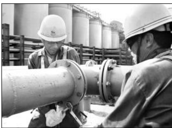
80万吨氧化铝厂五车间经过技术攻关,在新建碱液槽体内壁涂一层耐碱、耐腐蚀的保护层,将加热器材质更换为不锈钢。目前碱洗系统改造工程已近尾声,整个改造项目将于8月底竣工。图为检修人员正在对碱液槽上的管道进行检查。摄影报道 任卫红 范灵霞
