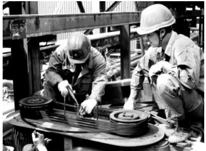
10月18日,氧化铝四分厂对32台拜尔法种分槽的运行状况进行了一次大规模的检查消缺。共检查清理处理滤油器31台、更换皮带8套、包扎处理接线盒32台,发现并处理其它电器隐患问题15项,为完成全年生产任务奠定了坚实的基础。图为员工在更换种分槽皮带。 摄影报道 赵萍
