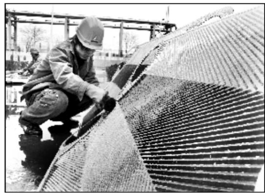
近日,80万吨氧化铝厂五车间对宽通道板式及板式换热器两种降温设备进行酸洗,保证了种分槽首、末槽温度能够控制在要求范围内,为种分分解率和出厂氧化铝铝度两项指标的完成创造了良好条件。图为检修人员正在对III组四级板式换热器拆下的板片进行刷洗。
