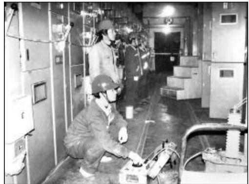
水电分厂电气检修车间2008年新的绩效方案的出台,以“我的绩效我创造”为主线,促进员工进行自我管理,激发员工的工作热情,在一年一度的春检工作中全体员工积极学习先进,增长技能,争创个人优秀绩效,使车间的各项管理又上新台阶。图为员工正在对开关柜进行耐压试验。
