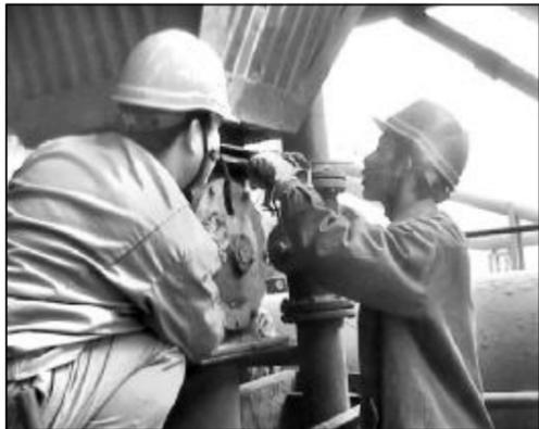
为确保氧化铝碳分生产系统稳定高产,提供高质量的CO<sub>2</sub>气,3月7日,氧化铝一分厂石灰炉车间眼睛向内,组织办公室人员及操作人员对大型炉气净化收尘器进行清理维护,确保首季生产任务的完成。图为炉气净化收尘器清理维护现场。
