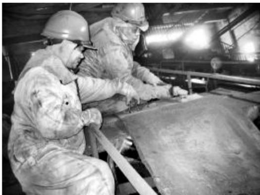
近日,热电厂针对二期皮带运行周期长,皮带带老化现象等问题,进行处理,共更换皮带50余米,确保了正常输煤。图为检修车间职工正在对二期6号皮带接口进行粘接。
