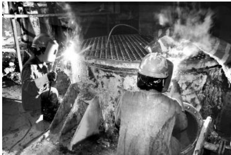
为了进一步提高设备运转率,近日,检修分厂压容一车间在四蒸发三组一效大修工程中优化焊接工艺,对气包等特殊部位采用氩弧焊打底等不同工艺,追求质量和工期实现新突破,该工程于4月5日开工,目前顺利进入回装阶段。预计5月2日完工。图为施工人员在精心焊接上部管板。摄影报道 陈永山 张安泽
